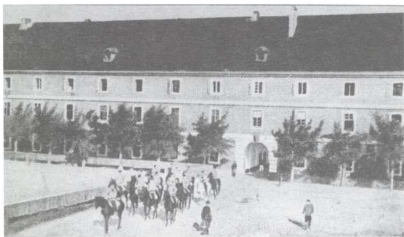
Jízdecká kasárna v Terezíně
